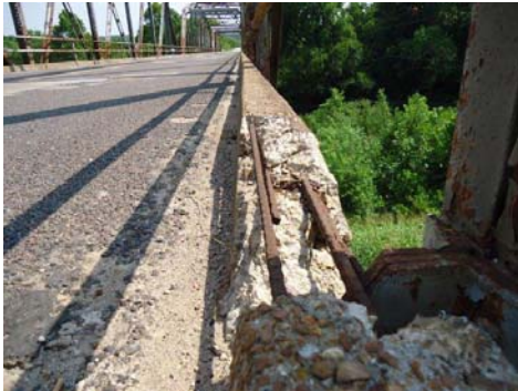
... mal entretenu (le ferrailage est apparent et rouillé), mais bien agréable
